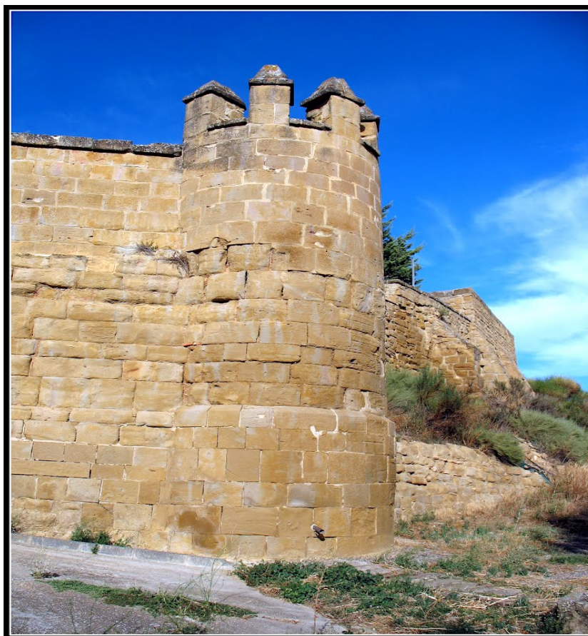
Figura 2. Muralla exterior del castillo de Siétamo (Huesca)
