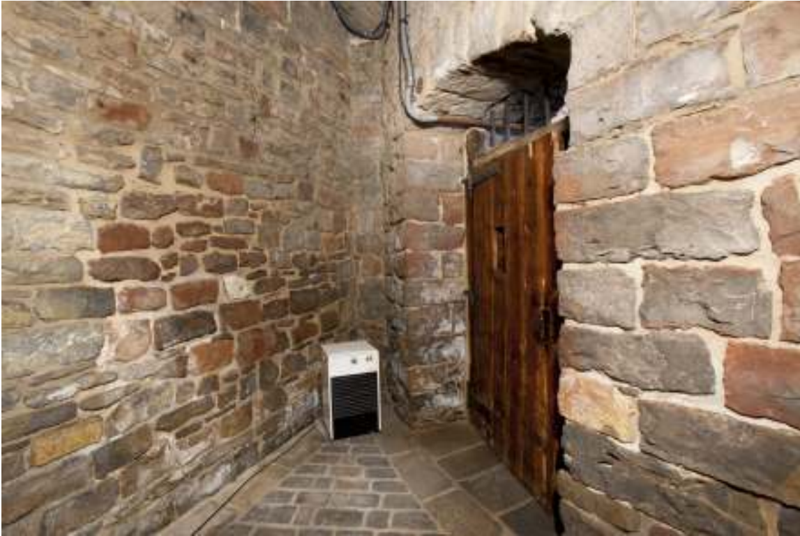
FOTO 8. PUERTA DE ACCESO A LA GARITA DE VIGILANTE
