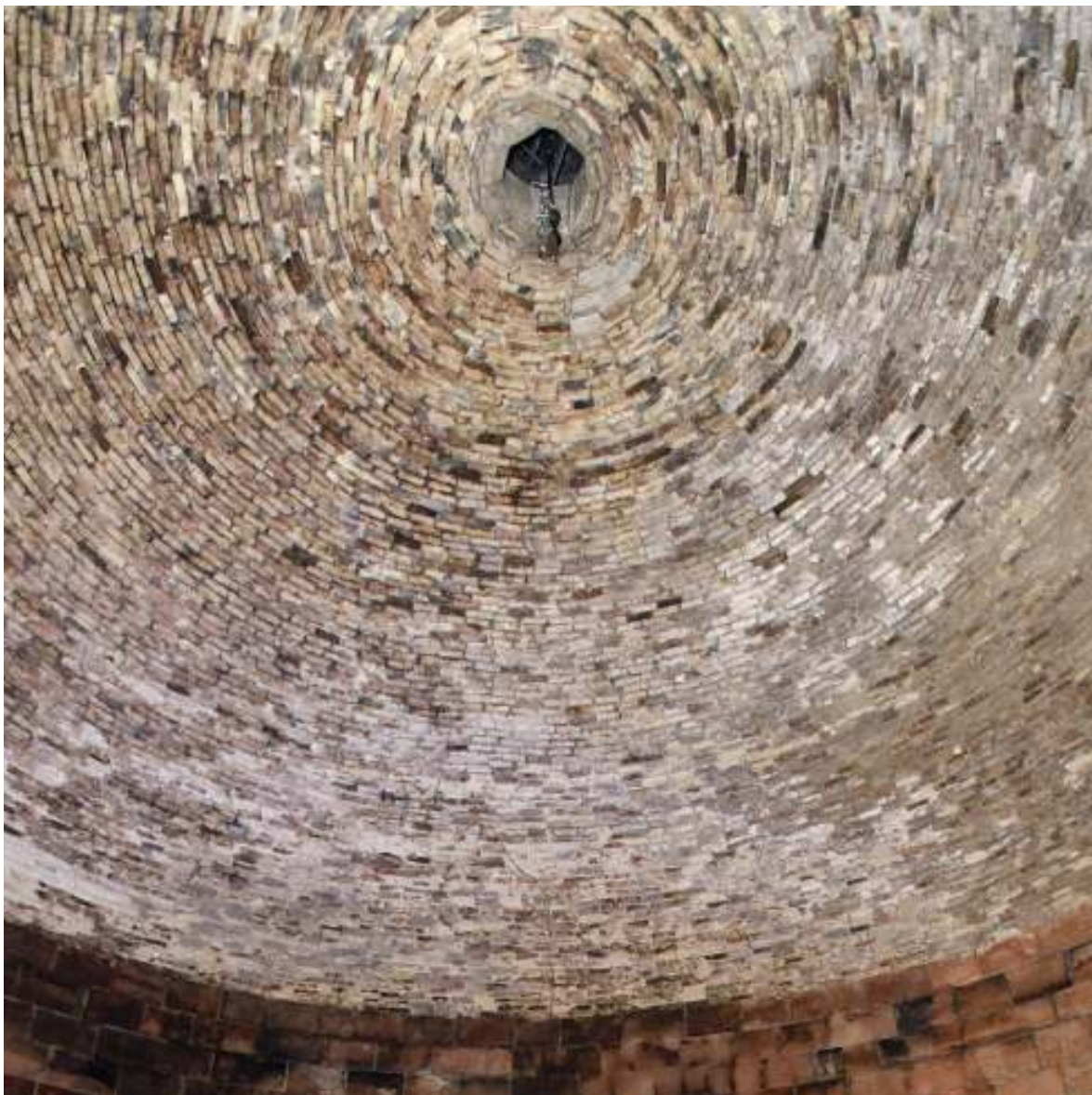
FOTO 10. CÚPULA, LINTERNA Y POLIPASTO
