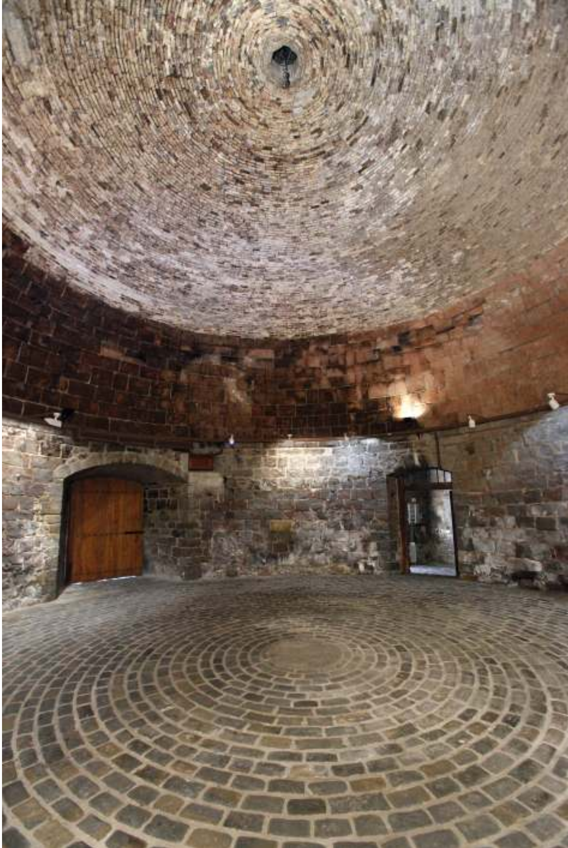
FOTO 10. CÚPULA, LINTERNA Y POLIPASTO
