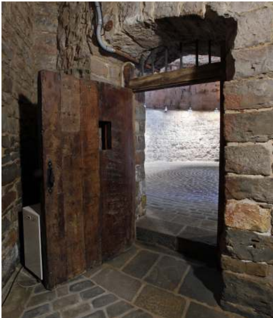
FOTO 7. VISTA DE LA SALA DESDE LA GARITA DE VIGILANCIA
